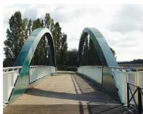
La passerelle au dessus de la RN118
