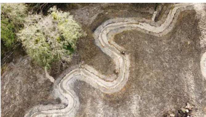
Reméandrage du ru de Vauhallaan, 2022 - © SIAVB
