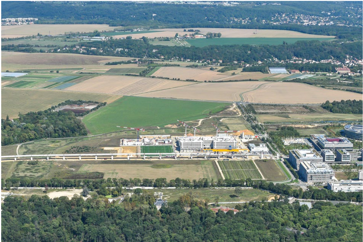
Le secteur Est de la ZAC de Corbeville, la Terrasse, le Cœur de Quartier et la Lisière/Hôpital (@Alticlic - EPA Paris-Saclay, septembre 2022)
