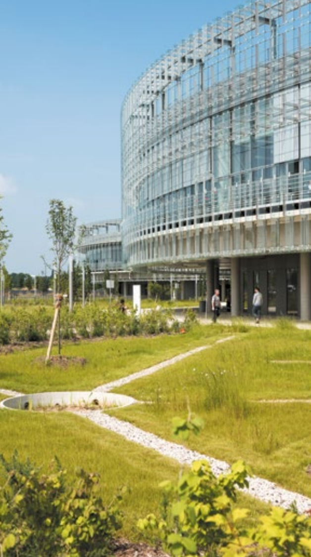
• fig.7 Le centre R&D d'EDF.
