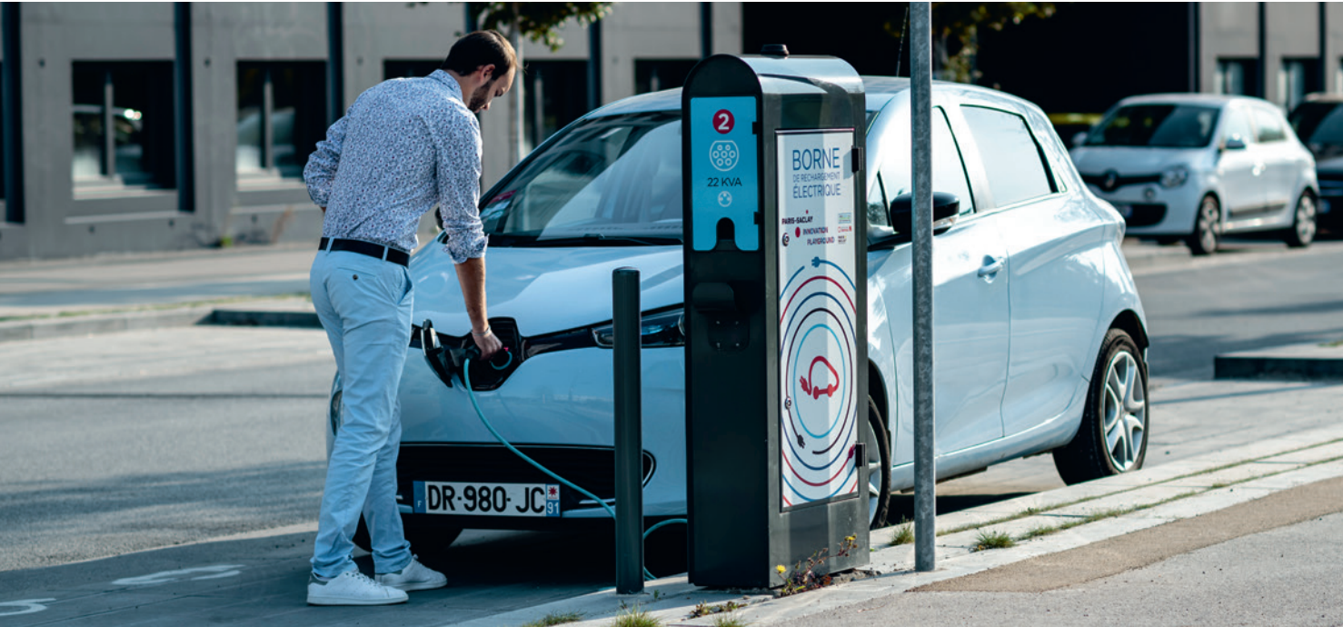
Le réseau de borne de recharge pour véhicules électriques du campus urbain
