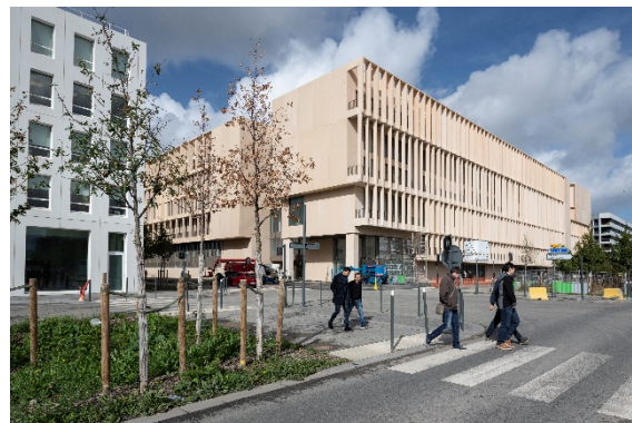
Institut Mines Télécom / Grafton Architects
