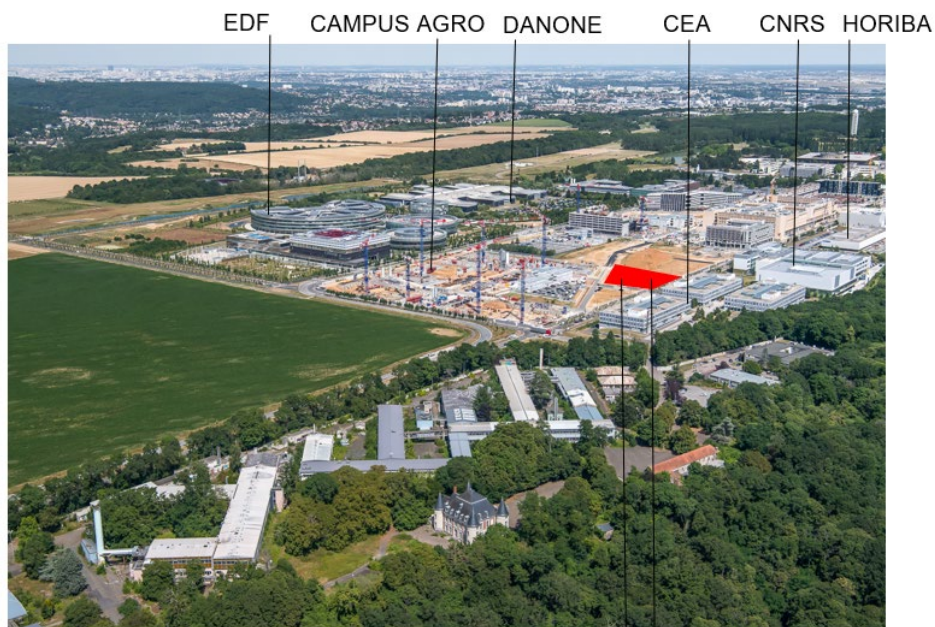
lot C13a – Incubateur Pépinière Hotel d'entreprise Lot C13b – Résidence nouveaux entrepreneurs et bureaux
