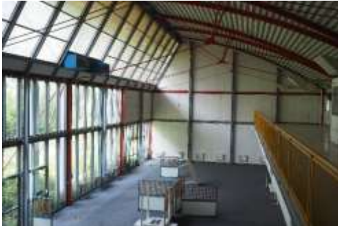
La Halle Piano d'entreprise à Guyacourt
