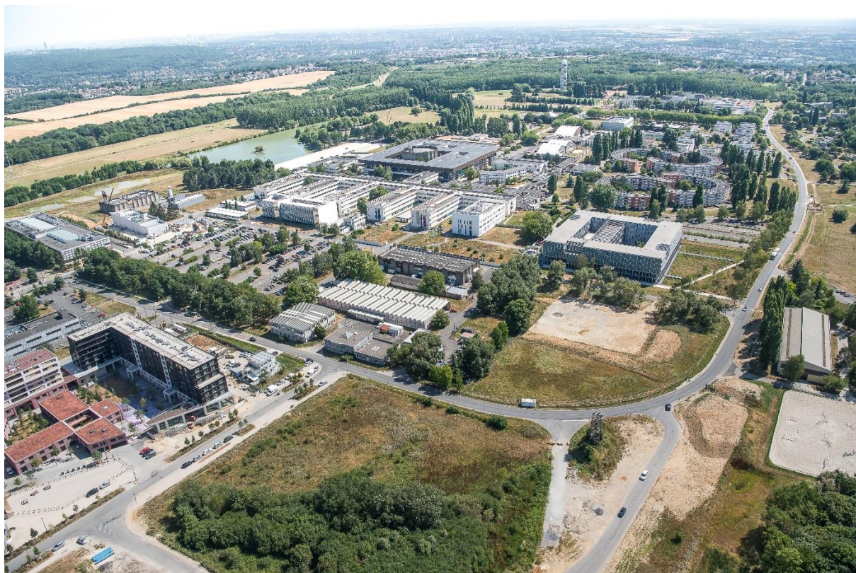
Vue aérienne du quartier de l'Ecole polytechnique ©EPA Paris-Saclay-Alticlic
